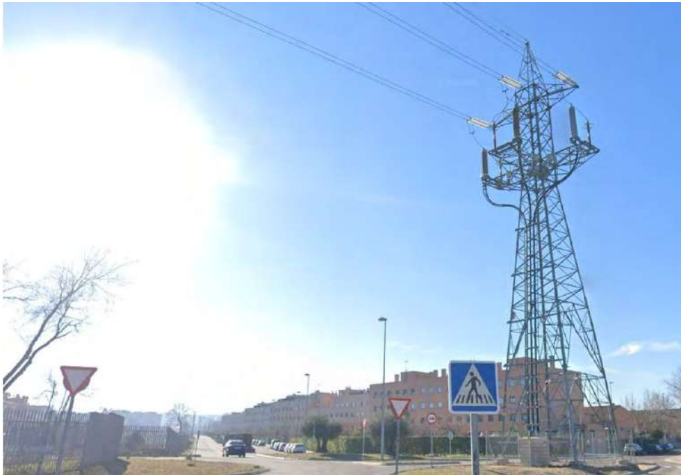
Foto 5: Línea MAT-1, paso por Av. de las Américas
