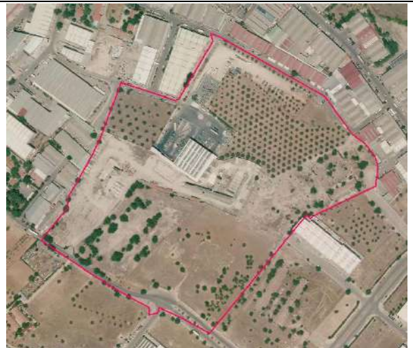
Situación actual de la UE-5: NO EJECUTADA.
