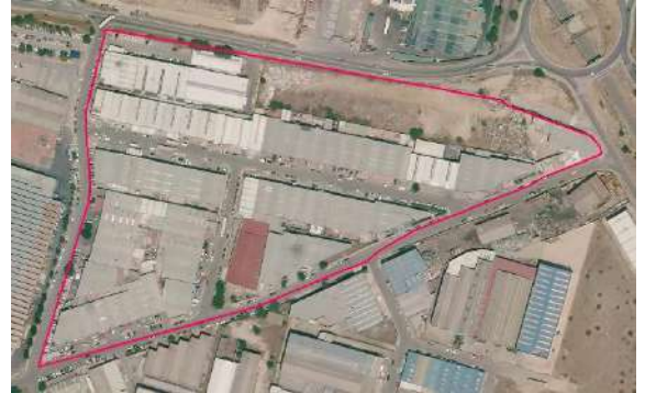
Situación actual de la UE-20: Parcialmente ejecutada.
