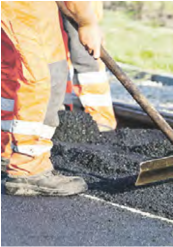
Trabajos de asfaltado
