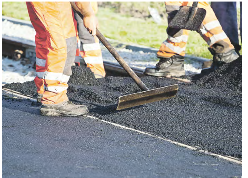
Obras de asfaltado
