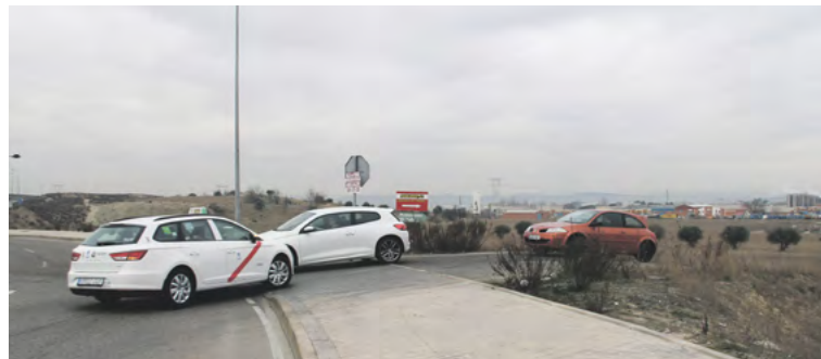
Detalle de la rotonda que da acceso al polígono
